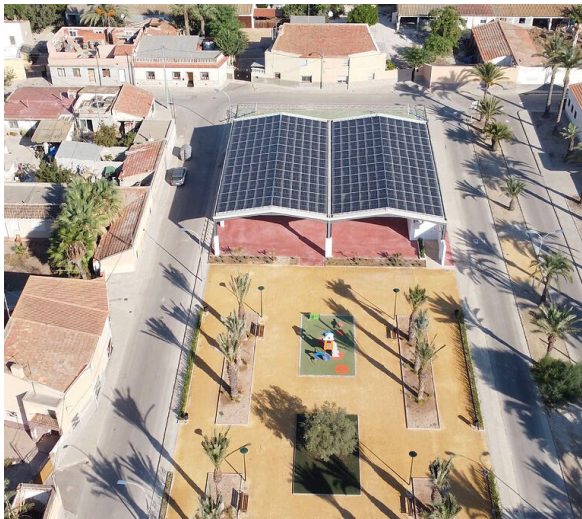
FOTOGRAFIA KOMPUTEROWA INSTALACJI . ŹRÓDŁO: GRUPA ENERCOOP
