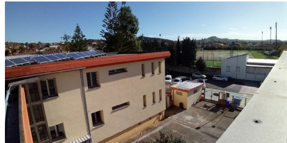
PHOTOVOLTAIC PANELS AUF DER PRIMÄR SCHULE IN DER GEMEINDE SERRENTI.
